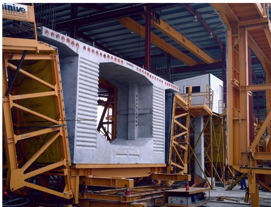
2,15 metros de espesor, con un peso aproximado de 100 t, cada una. La parte correspondiente a los voladizos laterales en esta zona del puente se ejecutará en una segunda fase, *in situ*, empleando encofrados de carros de alas.
